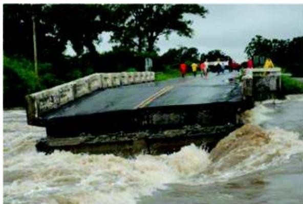
Colapso de un puente sobre la Ruta Nacional N° 11 en el cruce con el Arroyo Colastiné (marzo 2007). Las escasas dimensiones del puente hicieron que se produzca un rebasamiento del flujo sobre la estructura del puente, generando una falla generalizada del mismo ante el empuje hidrodinámico y los procesos de erosión general y local.
