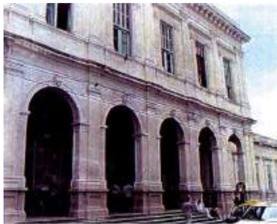
Vista Fachada Hospital de Clínicas. Área Alberdi Fuente: PROGUP – CEPLAT
